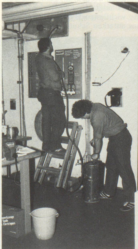
Die Chlorungssubstanz wird mittels Eimerspritze in den Tank gepumpt.
