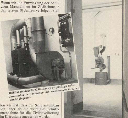
Kleinbelüftungsgerät der fünfziger Jahre. Petit appareil de ventilation des années cinquante.
