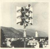
den mit hohem Schalldruck unverwechselbar ausgestrahlt und können manuell, mit einem Sirenenwarttableau, durch Funk oder mittels Fernwirksystem ausgelöst werden. Als Optionen bieten sich Sprachdurchsagen, spontan mit Mikrofon oder vorbereiteter Text ab Tonband an. Ebenfalls lässt sich der Feueralarm durch abgesetzte Meldetasten, mit Scheibe oder mit
