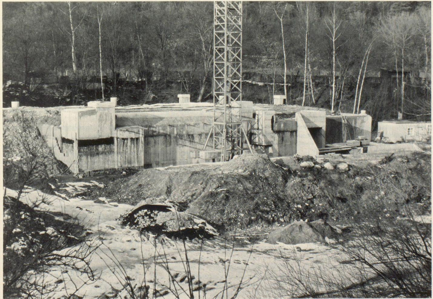
Zivilschutzanlage «Kiesgrube» (San Hist, Quartier KP mit BSA und öffentliche Schutzräume): eine Gesamtansicht im Rohbauzustand. Nach Fertigstellung der Anlage wird der ganze Bau überdeckt und begrünt.
