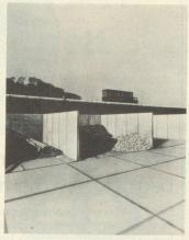
Die Stützmauern aus vorfabrizierten Betonelementen von 100 cm Breite und Höhen von 0,75 bis 4,00 m sind vielseitig einsetzbar. Ihre Winkelform garantiert Standfestigkeit und Mobilität. Zusammen mit den Fertigbodenelementen von 200×200×12 cm bilden sie ein System, das unserer Zeit entspricht und die Forderungen nach Wirtschaftlichkeit, Stabilität, Flexibilität und – last but not least – auch optischer Wirkung voll erfüllt.
