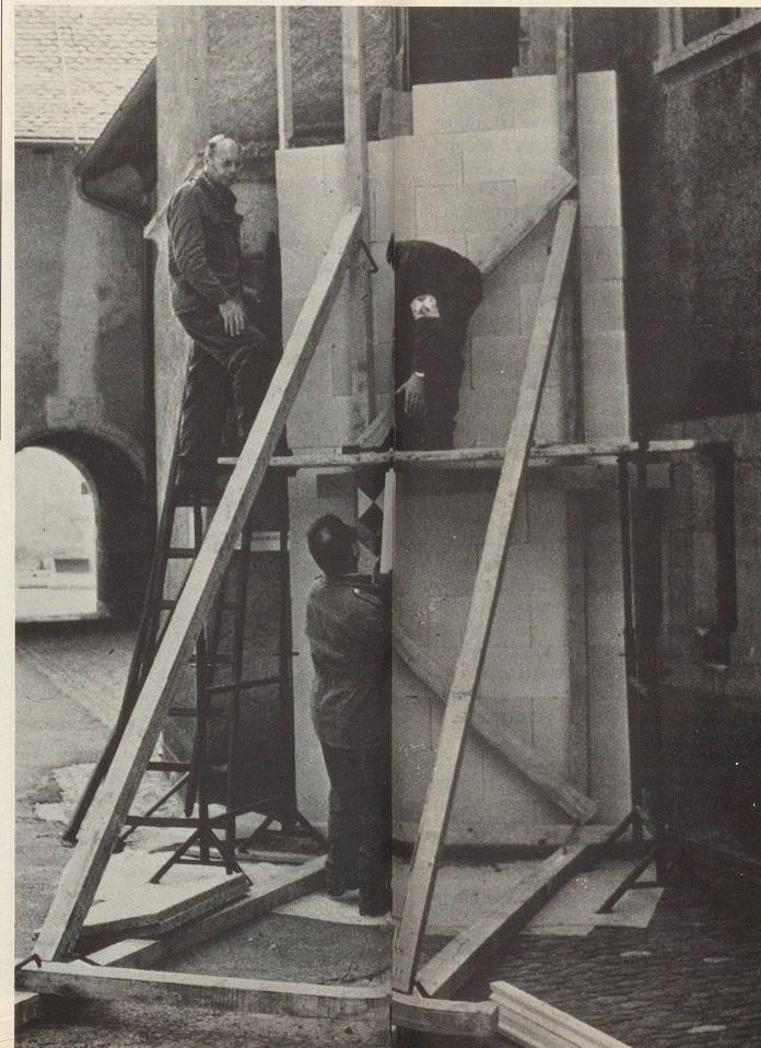
Vormauerung eines Splitterschutzes an einem Zierportal in Königsfelden durch KGS-Gruppe Windisch.
