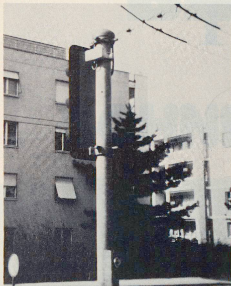
Die beiden Bilder zeigen eine Verkehrsampel mit Zivilschutz-Anschlusskästli.
