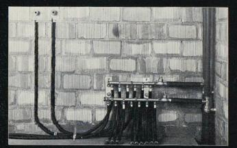
SANIPEX-System **DRG**® ist eine «Rohr in Rohr-Installation»
