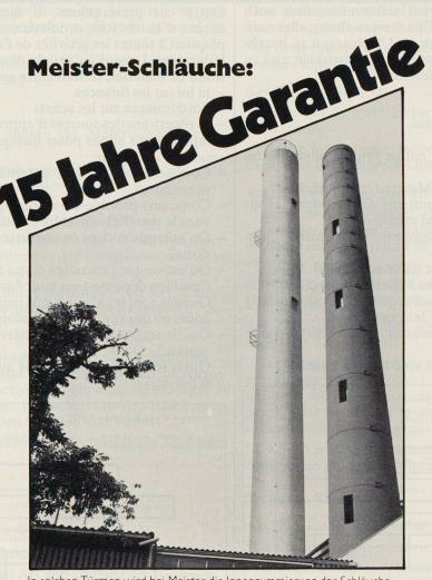
In solchen Türmen wird bei Meister die Innengummierung der Schläuche aufgetragen und vulkanisiert. Das Verfahren ist aufwendig, bringt aber entscheidende Qualitätsvorteile.
