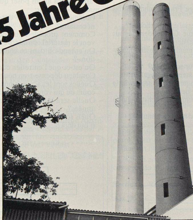
In solchen Türmen wird bei Meister die Innengummierung der Schläuche aufgetragen und vulkanisiert. Das Verfahren ist aufwendig, bringt aber entscheidende Qualitätsvorteile.
