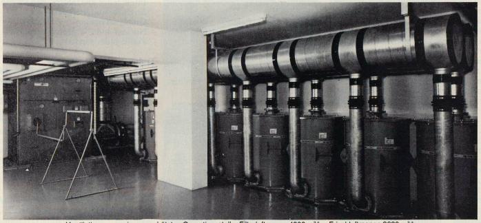
Ventilationsraum einer geschützten Operationsstelle. Filterluftmenge 4800 m³/h - Frischluftmenge 9600 m³/h.
