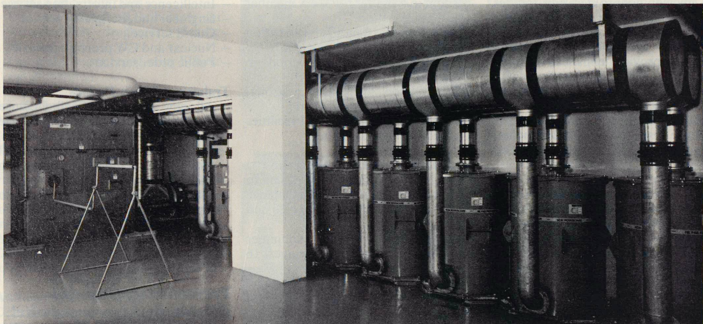
Ventilationsraum einer geschützten Operationsstelle. Filterluftmenge 4800 m 3 /h – Frischluftmenge 9600 m 3 /h.
