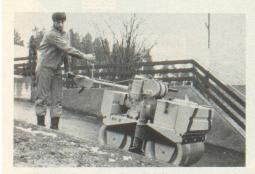
AMMANN-Tandem-Doppelvibrationswalze DTV-12 (Bild). Einsatzgewicht 900 kg. Kompakt, leicht bedienbar dank Mittelpunktlenkung. DTV-22 Einsatzgewicht 2200 kg, mit Sitz und Steuerrad.
