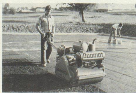
DUOMAT-Doppelvibrationswalze mit Einsatzgewichten von 580 und 1250 kg. R 66 mechanisch, DR 66 hydrostatisch angetrieben.
