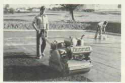
**DUOMAT-Doppelvibrationswalzen** mit Einsatzgewichten von 580 und 1250 kg. R 66 mechanisch, DR 66 hydrostatisch angetrieben.
