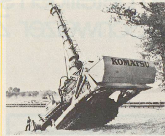
Abb. 2: Einsatz eines amphibischen Bulldozers zur Flussvertiefung in der Donau bei Wien.
