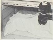
Abb. 2. Plastictank mit 1200 Liter Inhalt zur Aufnahme der Fäkalien. (Pressefotos Dr. Ing. Koenig AG, Dietikon)
