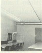
Schallabsorptionsplatten an der Decke eines Raumes in einem Kommandoposten.
