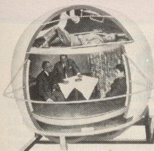
aus Stahlbeton-Fertigteilen, typengeprüft und genehmigt. Sicherheit gegen Luftdruckstöße S3, atomare, auch Neutronenstrahlungen, chemische und biologische Kampfstoffe. Einbauzeit: 1 Tag.
