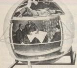
aus Stahlbeton-Fertigteilen, typengeprüft und genehmigt. Sicherheit gegen Luftdruckstösse S3, atomare, auch Neutronenstrahlungen, chemische und biologische Kampfstoffe. Einbauzeit: 1 Tag.
