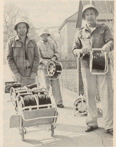
Pose d'une ligne téléphonique
