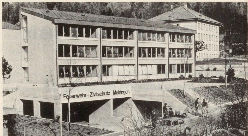
*Das neue Sekundarschulhaus in Meiringen mit den unter dem Pausenplatz befindlichen Zivilschutzanlagen. Rechts bei der Tanne befindet sich ein weiterer Ein- und Ausgang in den öffentlichen Schutzraum. Zur Anlage gehört auch ein Feuerwehrmagazin mit Schlauchtröcknungsanlage.*
