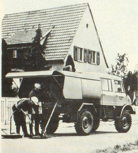
Unimog-Hochdruck-Kanalspüleinrichtung 1000-1200 m Tagesleistung.
