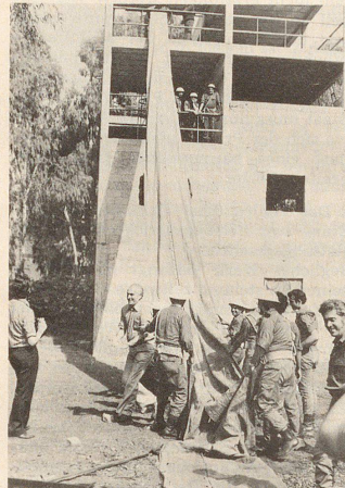
Neuer Rutschschlauch des israelischen Zivilschutzes zur Rettung von Personen in oberen Stockwerken. Bild aus dem Instruktionszentrum für Kaderausbildung der HAGA im Raum Tel Aviv
