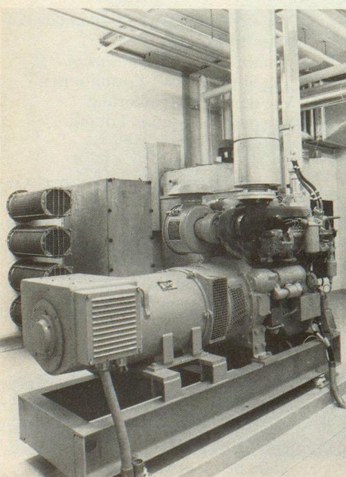
Caterpillar-Antriebseinheiten für alle Bedarfsfälle in Industrie, Baugewerbe, Traktion usw.
