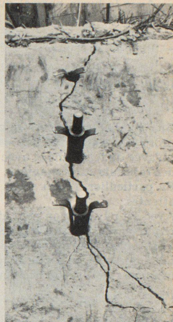
Fig. 30. Coins de clivage enfoncés. Pour couper les fers d'armature on n'utilise que le burin
