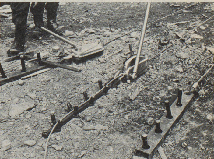
Fig. 43. Dispositifs d'ancrage de fortune et Titan
