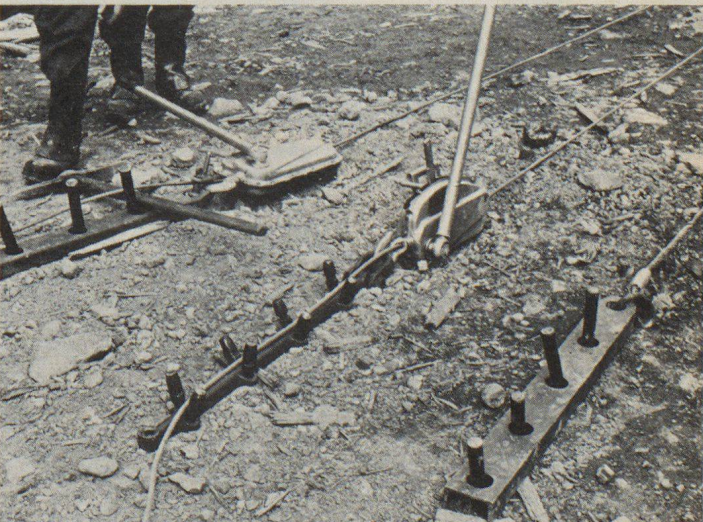
Fig. 43. Dispositifs d'ancrage de fortune et Titan
