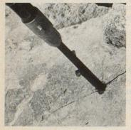
Abb. 25. Spaltkeil mit Abbauhammer A7 im Bohrloch
