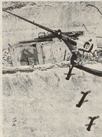
Abb. 29. Drei Bohrlöcher in armiertem Beton
