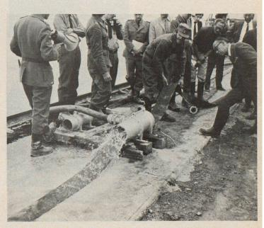
Abb. 17. Schlauchwaschapparat der Luftschutztruppe
