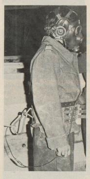
Abb. 22. Kopfhörergarnitur des Gasschutztelefons
