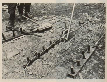
Abb. 43. Hilfsverankerungen und Titanverankerung
