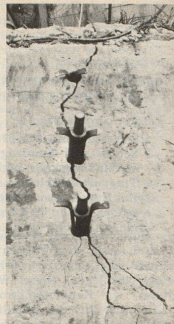
Abb. 30. Eindringene Spaltkeile. Zum Trennen der Armierungseisen wird nur das Schneideisen eingesetzt
