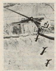
Abb. 29. Drei Bohrlöcher in armiertem Beton
