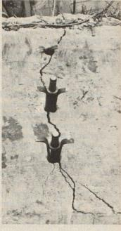
Abb. 30. Eingedrungene Spaltkeile. Zum Trennen der Armierungseisen wird nur das Schneideisen eingesetzt
