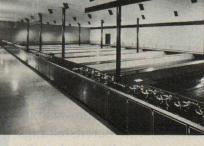
In Muttenz filtrieren Häny-Quarzsandfilter täglich rund 200000 m3 Wasser (Versorgungsgrundlage der Region Basel). Das Rohwasser wird dem Rhein entnommen, über offene Filter geleitet und zur Anreicherung des Grundwasserstromes im Hardwald zur Versickerung gebracht.
