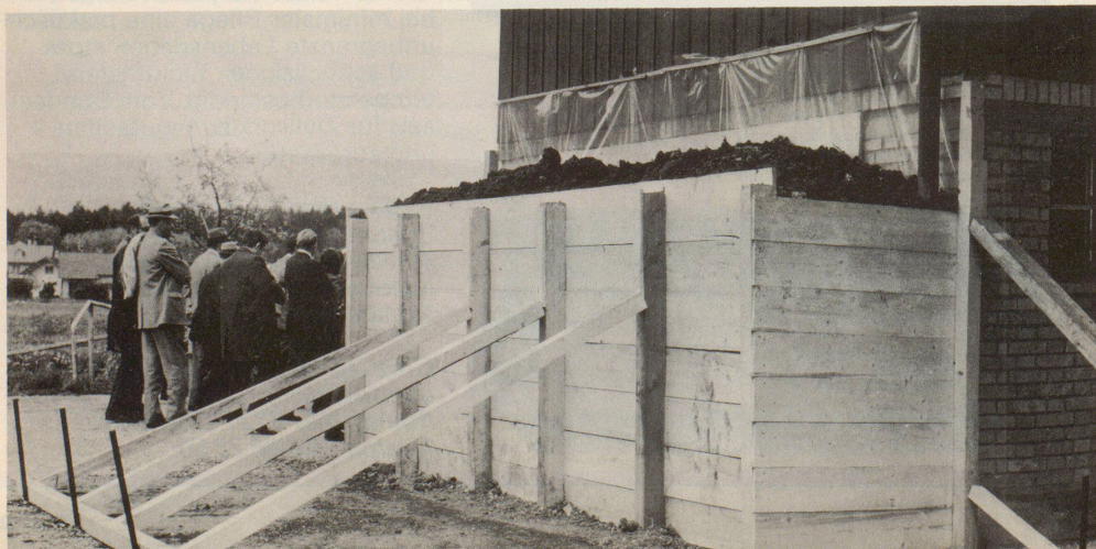
Beispiel der Verstärkung der Stallmauern, damit das Vieh besser gegen radioaktiven Ausfall geschützt ist. Ziegelsteine, Sandsäcke, Plasticfolien
