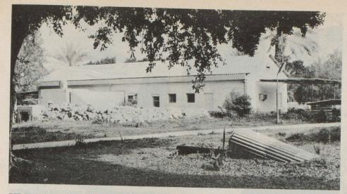
Wohnhaus des Kibbutz Zarubin. Davor ist die durch Steinbrocken verstärkte Ueberdachung des Schutzraumes zu erkennen, wie auch links aussen der Anbau, der in den Schutzraum führt.
