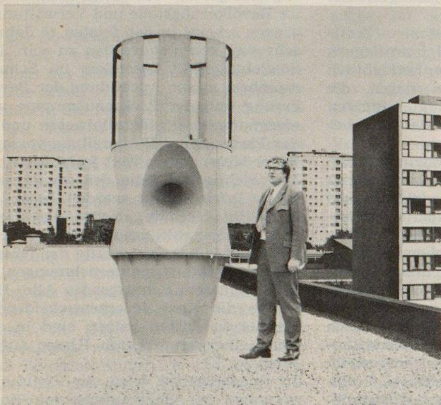
Modernste und lautstärkste Zivilschutz-Sirenen mit eigenem Dieselaggregat, Kompressor und Reserve-Luftbehälter
