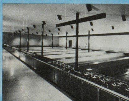
In Muttenz filtrieren Häny-Quarzsand filter täglich rund 200000 m<sup>3</sup> Wasser (Versorgungsgrundlage der Region Basel). Das Rohwasser wird dem Rhein entnommen, über offene Filter geleitet und zur Anreicherung des Grund wasserstromes im Hardwald zur Versickerung gebracht.
