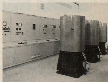
Vermehrt werden ruhiglaufende Wasserwerkspumpen verlangt. Weil die Pumpwerke oft bei Wohnsiedlungen liegen. Deshalb rüsten wir unsere Bohrlochpumpen mit Schwingungsdämpfern aus, oder wir liefern Tauchmotorpumpen, bei denen Pumpe und Motor direkt in den Grundwasserschacht versenkt werden. Bild: Seewasserpumpwerk Meilen.
