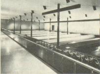
In Muttenz filtrieren Häny-Quarzsandfilter täglich rund 200000 m³ Wasser (Versorgungsgrundlage der Region Basel). Das Rohwasser wird dem Rhein entnommen, über offene Filter geleitet und zur Anreicherung des Grundwasserstromes im Hardwald zur Versickerung gebracht.
