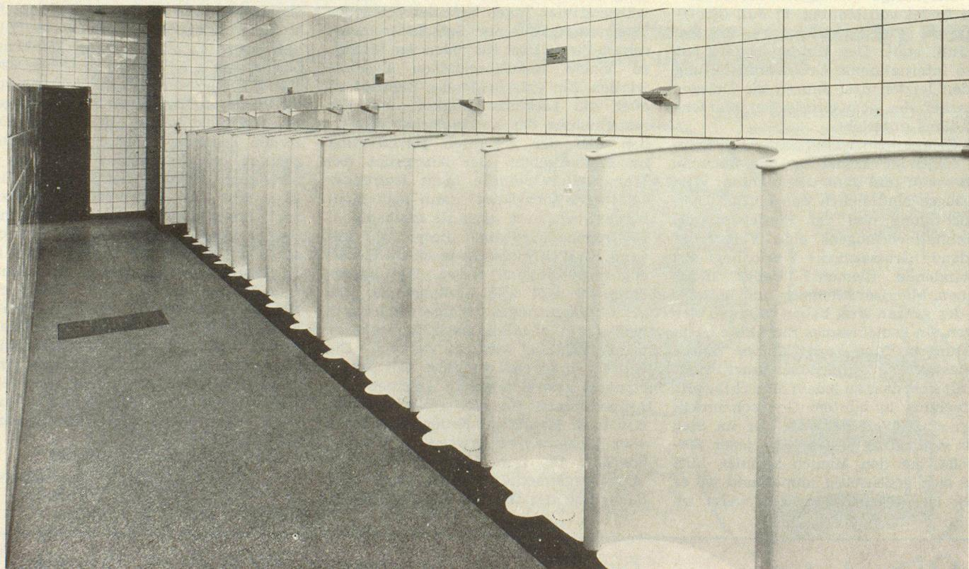
Urinanlagen «System Ernst» – ohne Wasserspülung absolut geruchlos – eignen sich speziell für Zivilschutzbauten
