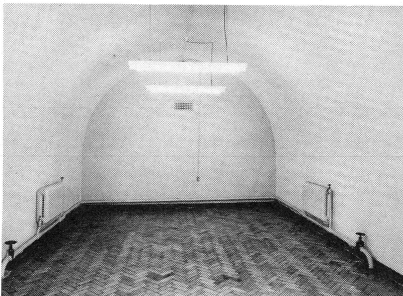
... wurde mit den IPA-Systemen so saniert, dass der Fussboden sogar mit Holzparkett ausgelegt werden konnte Werkphoto: IPA, München-Solln
