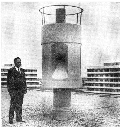
Modernste und lautstärkste Zivilschutz-Sirenen mit eigenem Dieselaggregat, Kompressor und Reserve-Luftbehälter (System Dipl. Ing. Hörmann).
