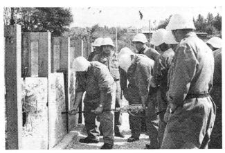
Einsatz des Bohrhammers an einem Betonelement. Um den Unfallgefahren zu begegnen und trotzdem die Hände zu schützen, wird der Bohrhammer mit zwei Plasticrohren versehen und auf die Handschuhe verzichtet
