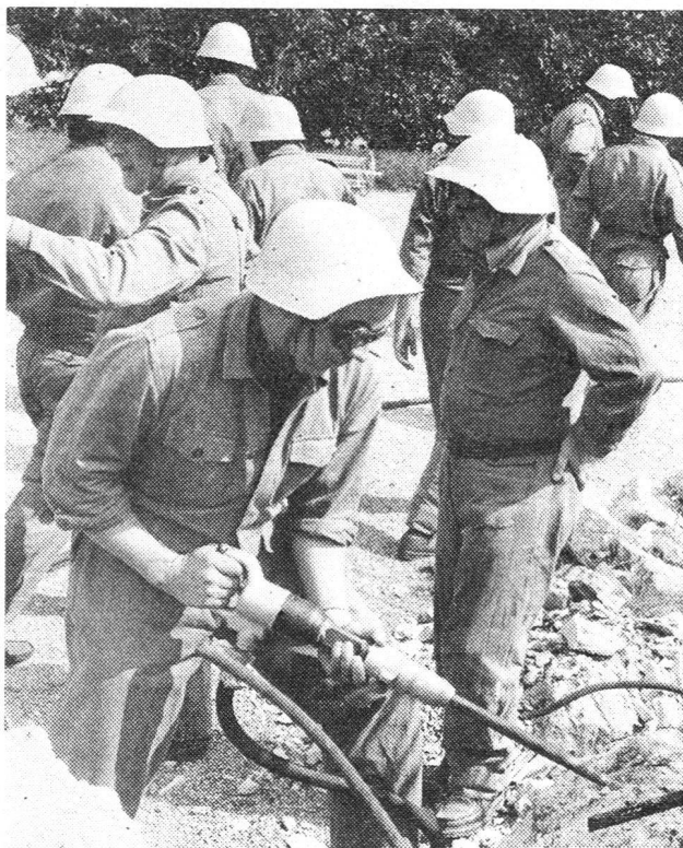
Einsatz pneumatischer Werkzeuge am Rande der Trümmerpiste
