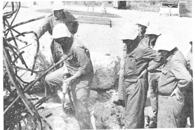
Einsatz pneumatischer Werkzeuge am Rande der Trümmerpiste
