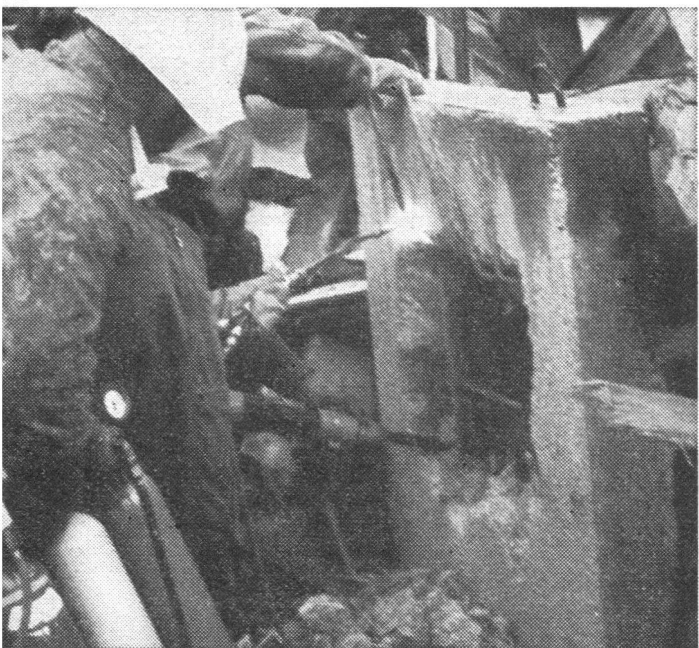
Mit dem Schweissbrenner wird der Durchgang in den Keller geöffnet.
