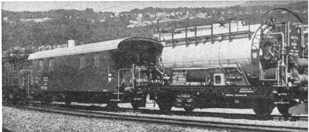
Der Tunnelrettungszug, der in Göschenen stationiert ist, setzt sich aus dem Triebfahrzeug, dem Rettungswagen und dem Tanklöschwagen zusammen. In erster Linie ist er zur Brandbekämpfung und für Rettungsarbeiten in Tunnels mit vergifteter Luft gebaut worden. Anlass zum Bau dieses Zuges gab die Katastrophe im Rickentunnel vom 4. Oktober 1926, wo bei Rettungsarbeiten neun Mann einer Kohlenoxydvergiftung zum Opfer fielen. Der Zug ist ein Prototyp. Der Bau weiterer Züge ist also vorgesehen.
