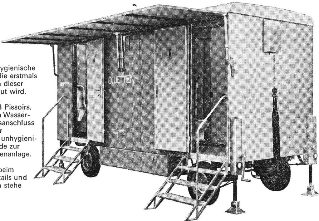
Die modernste, hygienische Toilettenanlage, die erstmals in der Schweiz in dieser Ausführung gebaut wird. 3 Damentoiletten, 1 Herrentoilette, 3 Pissoirs, alles mit direktem Wasser- und Kanalisationsanschluss sowie elektrischer Beleuchtung. Die unhygienische Latrine wurde zur modernen Toilettenanlage.
