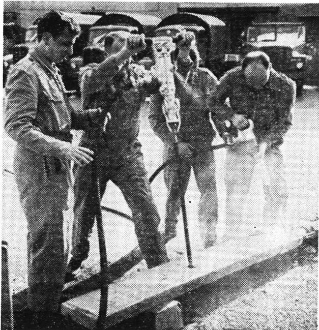
An die Kompressoren werden im Einsatz Bohr- und Abbauhämmer angeschlossen. Es können damit auch die Tauchpumpen der Motorspritzen in Betrieb gesetzt werden
