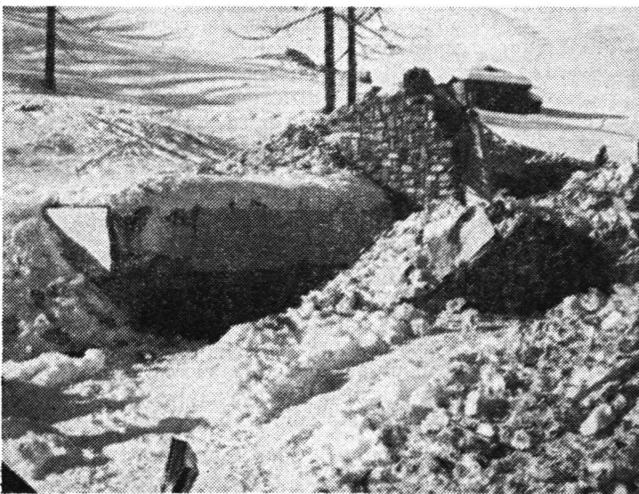
Obergeschoss weggefeht, zwei Tote; Untergeschoss inklusive Schutzraum intakt
