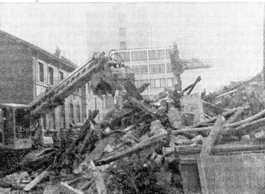
In einer zweiten Phase der Ausbildung werden auch moderne Baumaschinen eingesetzt, welche die Trümmerberge abtragen, Durchgänge in die eingestürzten Häuserreihen reißen und der Truppe ermöglichen, rasch an verschüttete Kellerräume heranzukommen und Menschen zu bergen.
