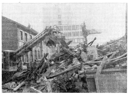
In einer zweiten Phase der Ausbildung werden auch moderne Baumaschinen eingesetzt, welche die Trümmerberge abtragen, Durchgänge in die eingestürzten Häuserreihen reissen und der Truppe ermöglichen, rasch an verschüttete Kellerräume heranzukommen und Menschen zu bergen.
