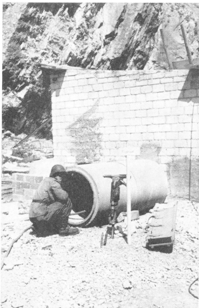
Das ist die «Klagemauer», an der im engsten Raum unter Einsatz von Pressluftbohrern oder andern Mitteln Mauerdurchbrüche geübt werden.
