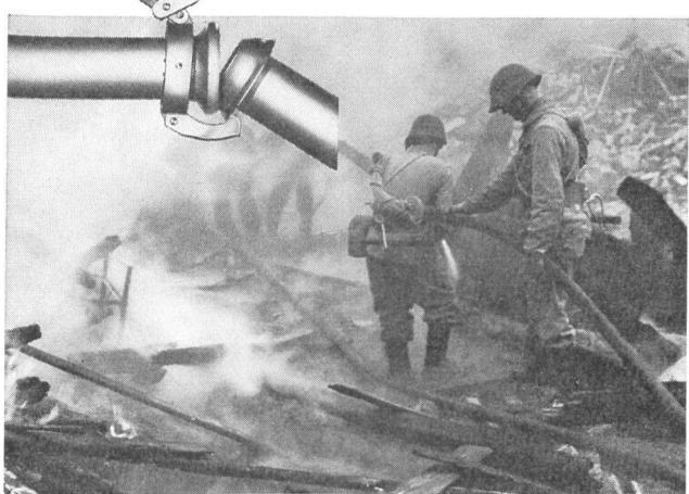
aus blankgeglühtem Kaltbandstahl mit einer Festigkeit von etwa 40-50 kg/mm<sup>2</sup>. Rohrlängen 6 m, in feuerverzinkter Ausführung, gemäss den eidg. Vorschriften der Abteilung für Luftschutz.
