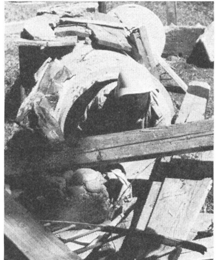
Sorgfältige Trümmerberäumung über einem Verschütteten nach Ueberwindung der mit verschiedenen Trümmern versperrten Fuchsröhre.
