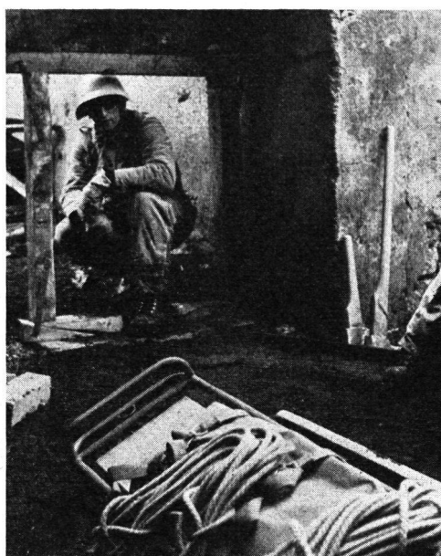
Von Trümmern befreite Durchgänge werden sauber mit zurechtgesägten Balken abgestützt, damit sie für den Nachschub und den Rückzug gesichert erhalten bleiben und kein Mauerwerk nachstürzt.
