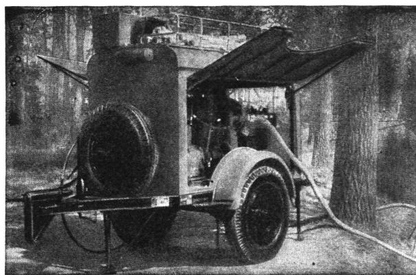
Trinkwasserbereiter mit elektrolytischer Chlorerzeugung 10 m<sup>3</sup>/h. Eingeführt zur Truppenwasserversorgung und zum Bevölkerungsschutz in vielen Ländern.
