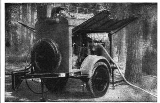
Trinkwasserbereiter mit elektrolytischer Chlorerzeugung 10 m²/h. Eingeführt zur Truppenwasserversorgung und zum Bevölkerungsschutz in vielen Ländern.
