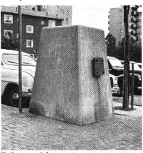
Trümmersicherer Ausstieg aus einem Schutzraum in Vällingby.
