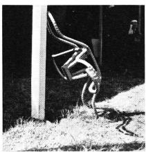
Krone für Verstärkerpfosten, wie er in die Decke betoniert werden kann.
