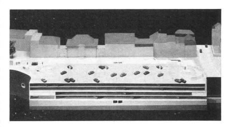
Schnitt durch die Parkierungs- und Zivilschutzanlage. (Modellphoto, Photo Hinz SWB, Basel) Die Schutzraumdecke von 1 m Stärke über dem 4. Untergeschoss ist deutlich erkennbar.
