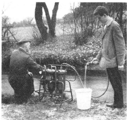
Kompaniewasserfilter nach dem Anschwemmverfahren mit entkeimendem Filtermittel.
