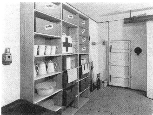
«Küche» mit Essgeschirrkisten und einem Teil des Notvorrates. Rechts oben ein Zuluftrohr, darunter das der Abluft dienende Ueberdruckventil.
