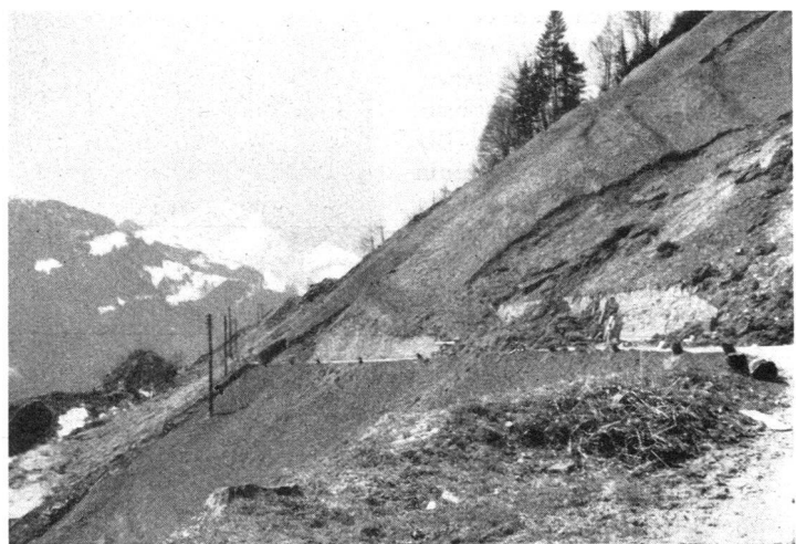
Die Alpstrasse beim Uebergang ins Rutschgebiet Der fruchtbare Humusboden ist abgesunken und rutscht gegen das Schraubachtobel hinunter.
