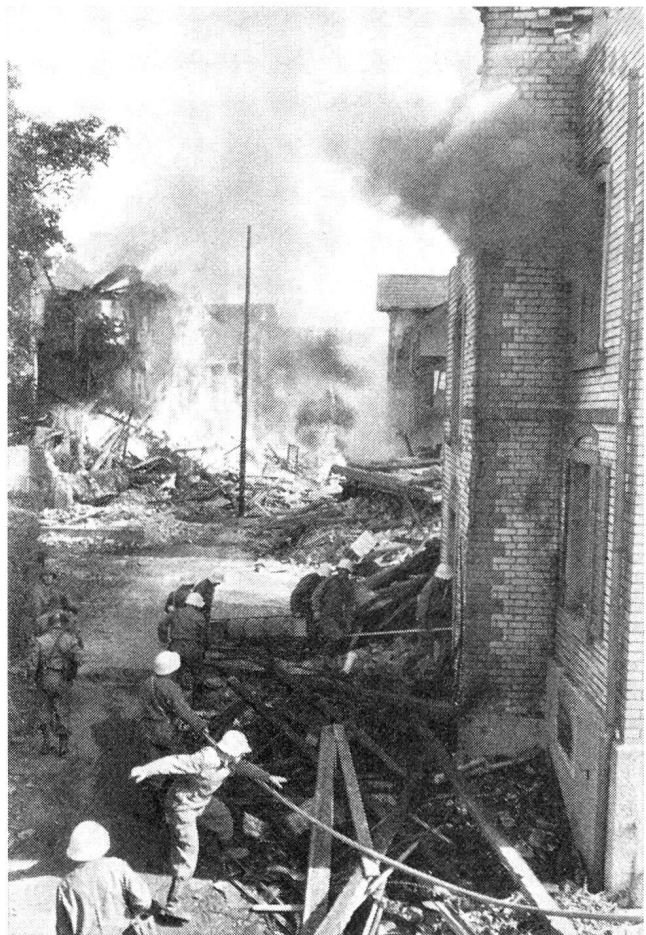
Abb. 4. Blick in den Einsatzraum, wie er sich den Gästen von der Tribüne aus bot. Im Vordergrund setzt eben die Hauswehr ein, links der Übungsleiter, der Kommandant der Einsatzkompanie und der Zugführer des ersteinsetzenden leichten Luftschutzzuges. Im Hintergrund entwickelt sich die Feuerbarriere; rechts davon das Haus, dessen dem Betrachter zugekehrte Fassade eben eingesprengt wurde. Darüber, frei hängend, der Teil des Dachstockes, der später als Folge des Brandes einstürzte
