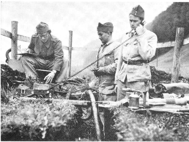
TT-Betriebsgruppe bei der Reparatur eines Kabels
