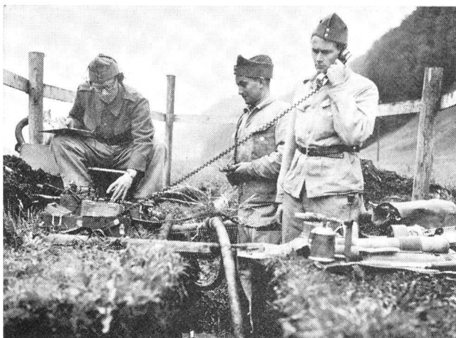
TT-Betriebsgruppe bei der Reparatur eines Kabels
